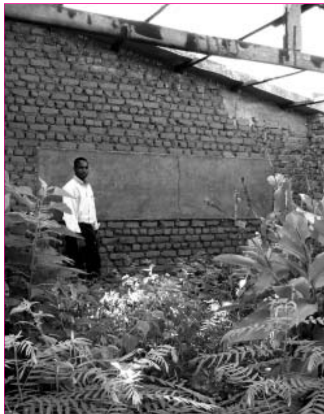
Interno di una ex-scuola.
